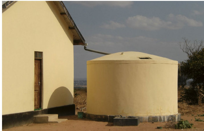
▲ Regenwassertank an der Schule von Mtipa
